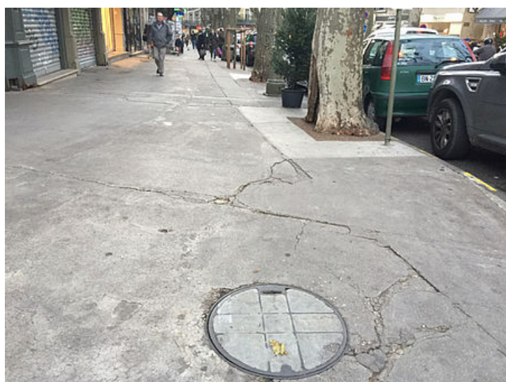
Côté impair, l'ensemble des trottoirs de la chaussée sera entièrement pavé pour harmoniser le centre-ville.
