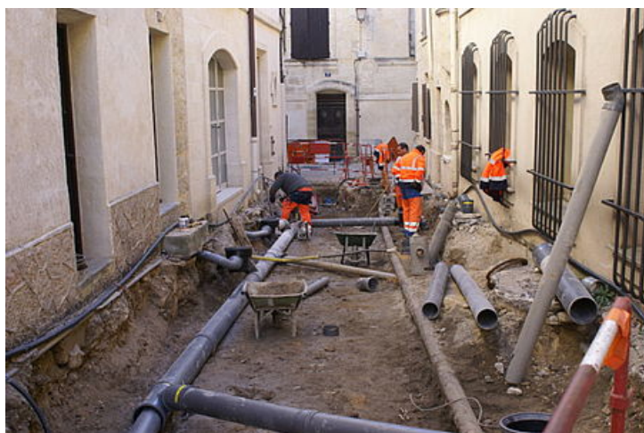
Rue Saint Roman en cours de réhabilitation
