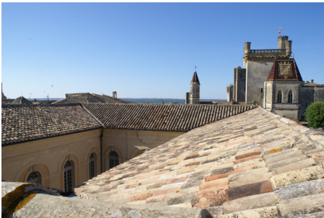
La réfection intégrale de la toiture de la mairie aura duré sept ans.
