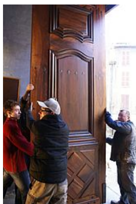
La remise en place d'un des vantaux.
