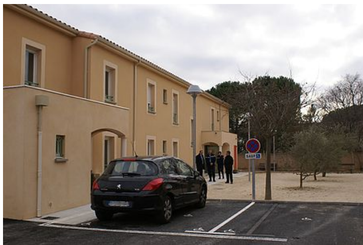
Cinq nouveaux logements construits
