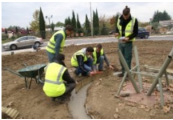
Rond-point de Pont des charrettes : les élèves du Grand Mas réalisent la deuxième partie de l'aménagement qui sera livré mi-avril
