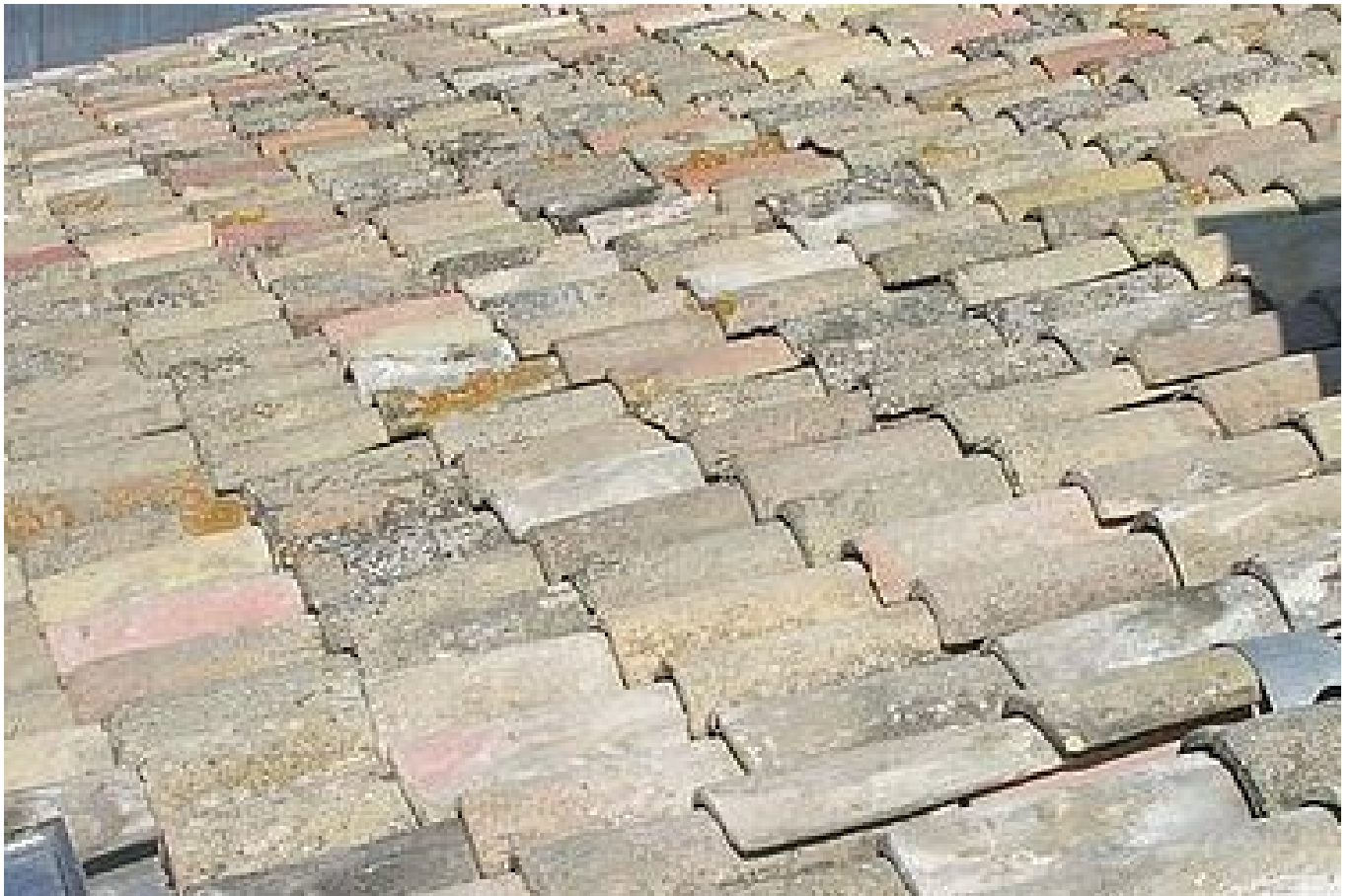
La quatrième tranche de la toiture de l'Hôtel de ville entièrement restaurée
