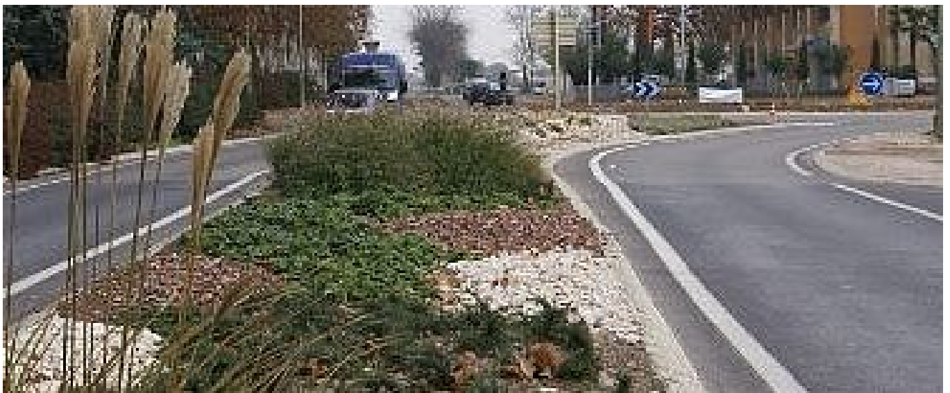
Uzès : aménagement durable du terre plein de Pont des Charrettes
