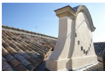
Fin mars 2011, la troisième tranche des travaux de la toiture de l'Hôtel de Ville était réalisée
