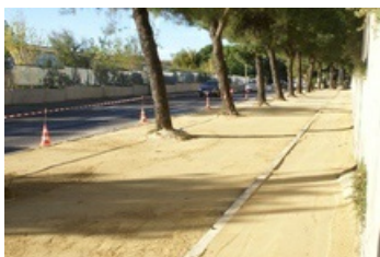
Amélioration de l'avenue Georges Pompidou
