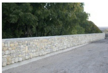
Le mur de soutènement du parking du Serrebonnet
