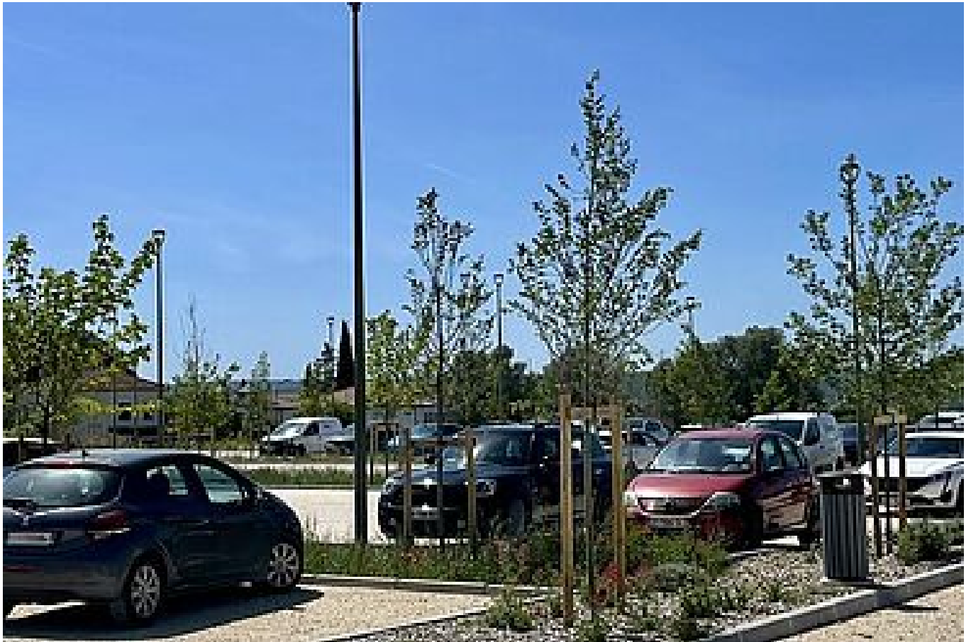
Création du Parking Pompidou
