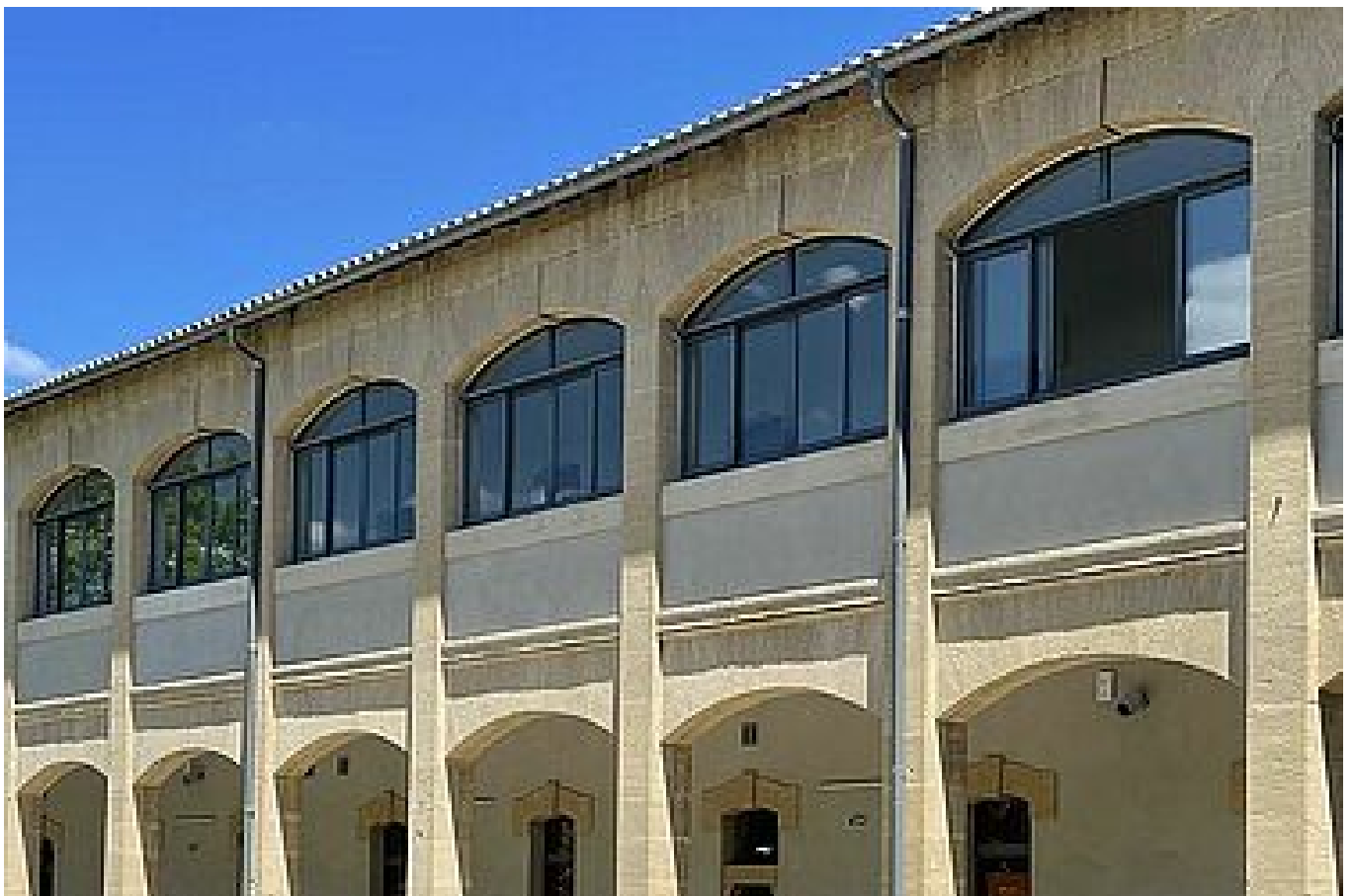
Rénovation du Groupe scolaire Jean Macé
