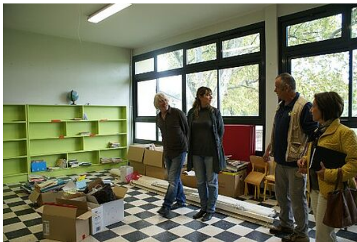
Aménagement de la nouvelle BCD et de la salle de projection. Pose de nouvelles fenêtres isolantes.
