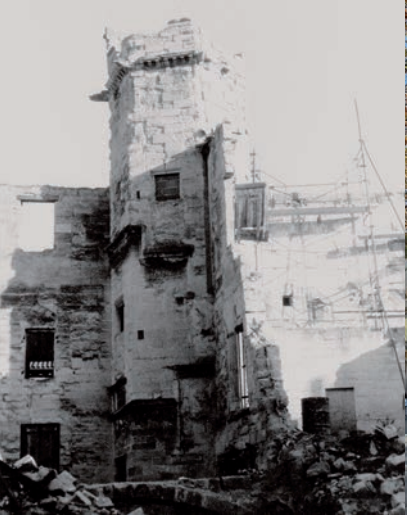
Stadthaus Hôtel de Roche in der Rue Paul Foussat vor seiner Restaurierung
