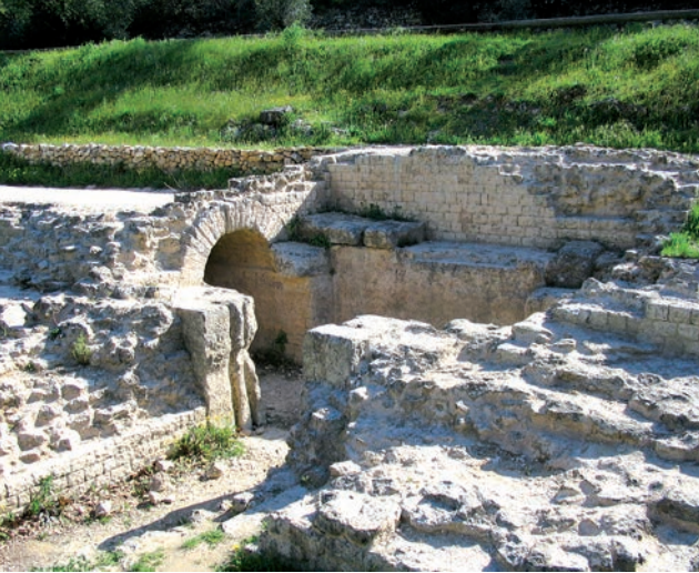
Staubecken des römischen Aquädukts im Eure-Tal zur Regulierung der Durchflussmenge, der Umleitung überflüssigen Wassers in den Alzon und der Schließung des Aquädukts zu Reinigungs- und Wartungszwecken
