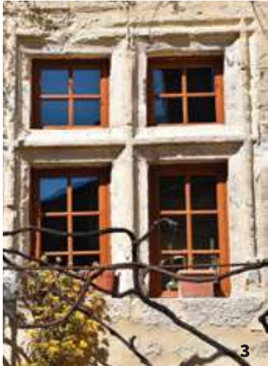
3. Fenêtre à meneaux © Maison du patrimoine – Ville d'Uzès
