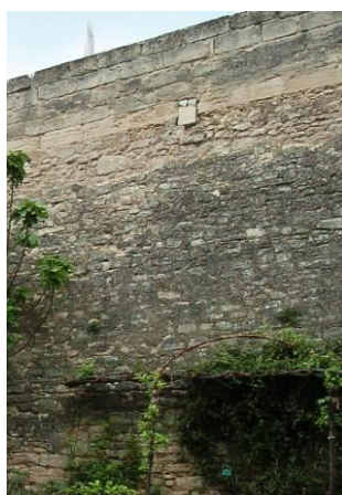
Mur moellonné. Courtine est du château (tour du Roi Tour de l'Evêque). Maçonnerie moellonnée destinée à rester apparente.
