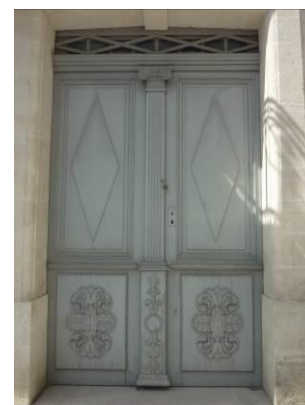
4, place d'Austerlitz. Vantaux du 19 e siècle.
