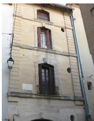
Un chaulage des pierres de taille situées en remplissage, unifie les panneaux pour faire ressortir les chaînages et bandeaux. 12, rue Sigalon.
