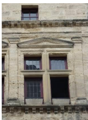
Un châssis bois par unité, avec carreaux mis en plomb. 6, rue Nicolas Froment.
