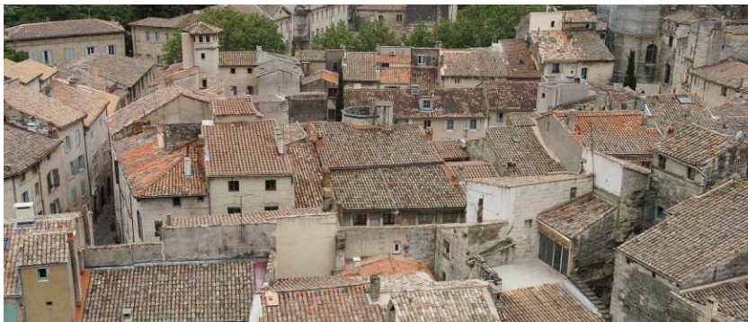
Les couvertures des immeubles sont visibles de toute part.
