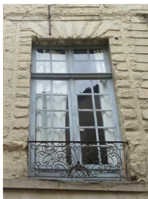
Grande menuiserie de fenêtre 17 e siècle : fenêtres à « petits carreaux » et imposte. 7, rue Saint-Etienne.
