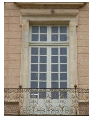
Grande baie 18 e siècle. Menuiserie à « petits carreaux » et imposte. Palais épiscopal.
