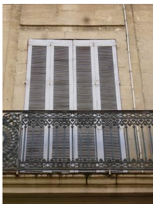
11, boulevard Gambetta. Ferronnerie Restauration (vers 1820-30).
