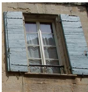
Volets à larges planches croisées. 5, rue Petite Bourgade.
