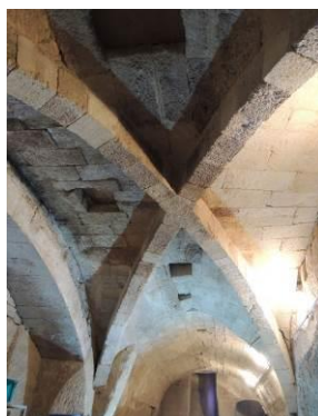
9, rue Pélisserie. Cave 1. Croisée d'ogives primitives de section rectangulaire et clef cruciforme.
