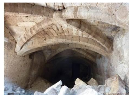
Caves sous voûte sur croisée d'ogives chanfreinées (fin 13e siècle – début 14e siècle)
