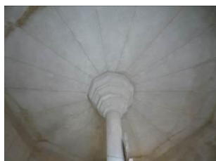
L'extrémité supérieure de l'escalier. 4, rue Saint-Théodorit.
