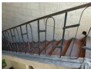
23, rue du Docteur Blanchard. Rampe du 18 e siècle.
