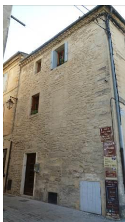
22, boulevard Charles Gide. Façade latérale moellonnée prévue pour être enduite.
