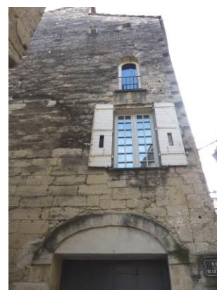
2, rue de la Calade. Maison romane. Façade en pierre de taille.
