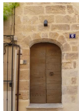
4 Appareil du 16 e siècle. 6, rue Grande Bourgade
