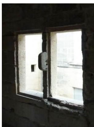
Les battants des châssis ouvrants des fenêtres « à meneau » s'inscrivent directement dans les feuillures du tableau. 15, rue du Docteur Blanchard.
