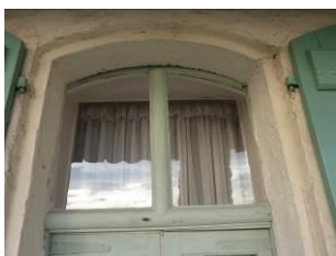
Aux 18 e siècle, le linteau s'arrondit en arc segmentaire. La menuiserie épouse la courbe. 5, rue des Capucins-Vieux.
