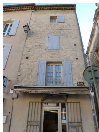
2, boulevard Charles Gide. Façade principale moellonnée destinée à être enduite.
