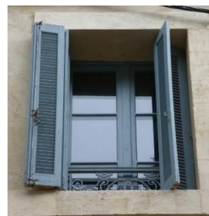
Volets pliants persiennés. 4 avenue Jean-Jaurès.
