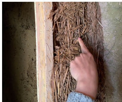
Remplissage d'une cloison
