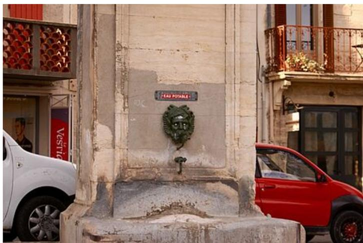
La fontaine subira plusieurs étapes pour être remise à neuf. L'eau y est potable et l'entretien du réseau d'eau en fait partie. Les travaux ont débuté par *"un nettoyage à basse pression et un brossage manuel pour ne pas aggraver l'épiderme de la pierre. Les pierres étant superposées, elles ont entraîné une dégradation du fer"*
