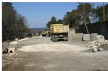
Au nord-est de la ville, les travaux d'aménagement du parking du Serrebonnet ont débuté. Ils sont réalisés par l'entreprise Lautier Moussac qui a pour tâches la démolition du mur d'entrée, la réparation du mur de soutènement, la réalisation du réseau pluvial, la mise en place de bordure et du revêtement du parking, ainsi que la création d'espaces verts. D'ici la fin du mois d'avril, une quarantaine de places de stationnement, dont trois pour handicapés, seront disponibles.
